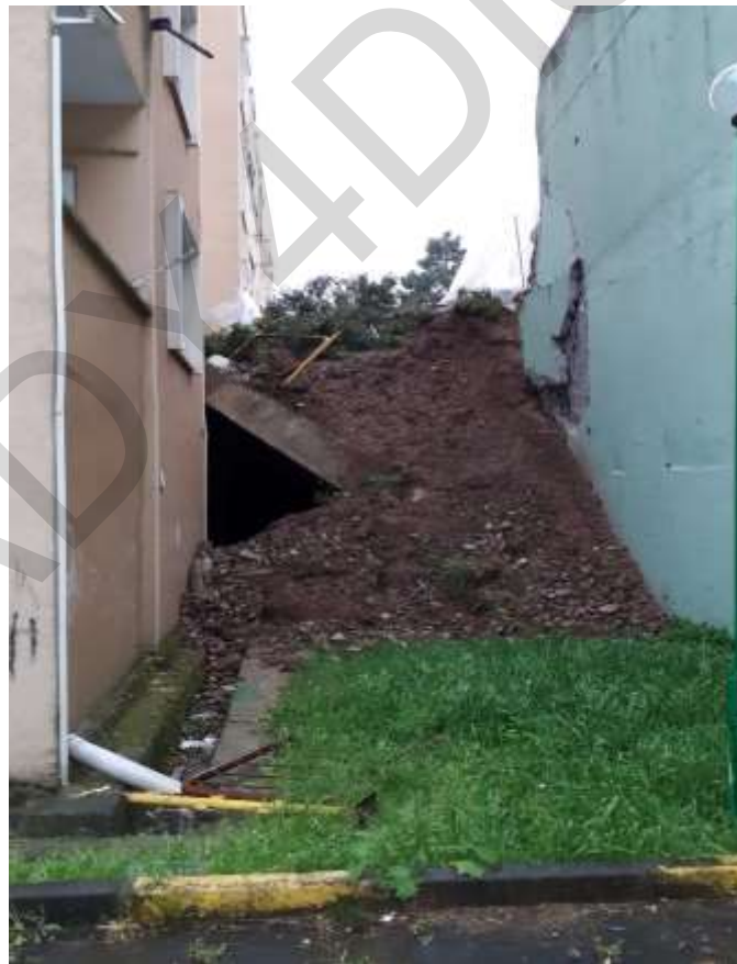
სურათი 3.18. ჩამონგრეული საყრდენი კედელი და მეწყერი
